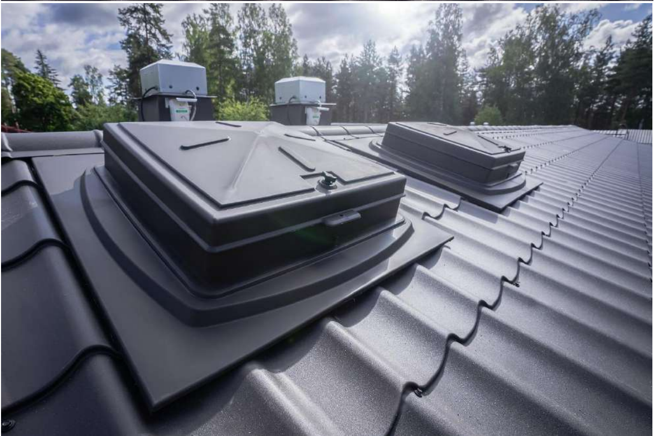
Kuvat 11 ja 12. Plastec kattoluukku asennettuna tiilikuviopellille
