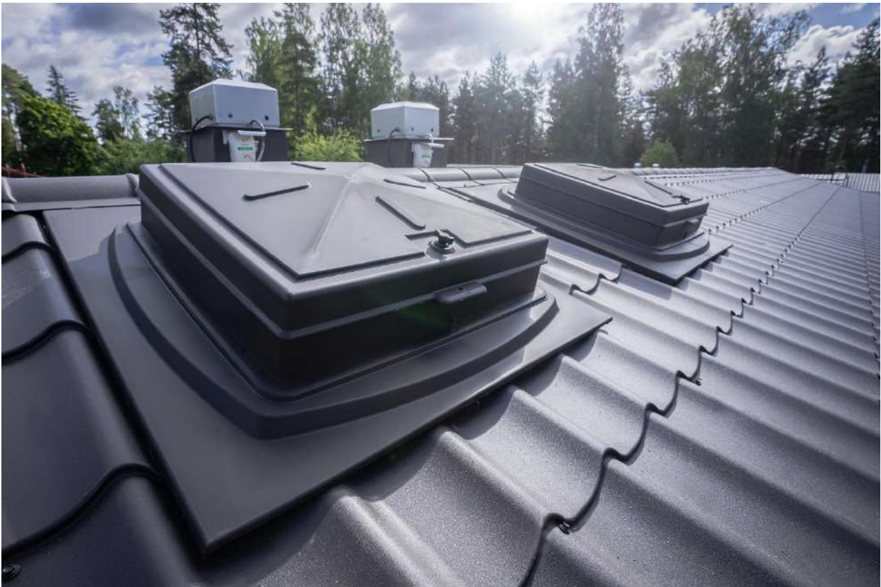
Kuvat 11. Plastec kattoluukku asennettuna tiilikuviopellille
